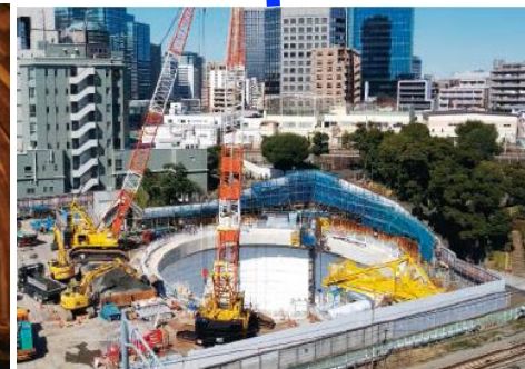
北品川非常口の工事
